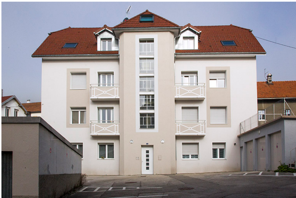
Bâtiment nord : façade antérieure.
