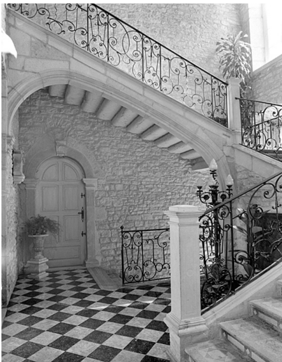
Bâtiments conventuels. Escalier : vue générale.
