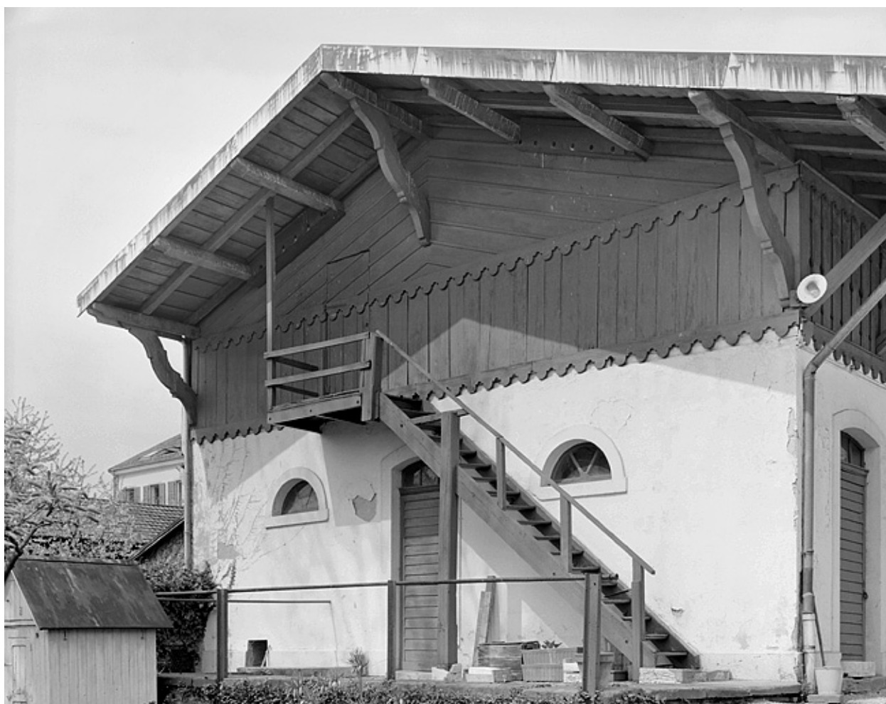
Remise à voitures. Façade sud.
