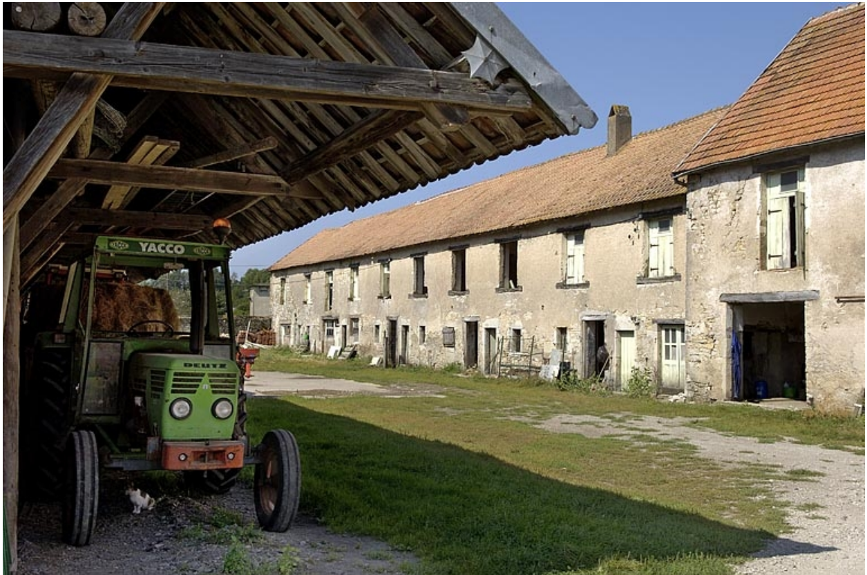
Aile ouest des logements ouvriers.
