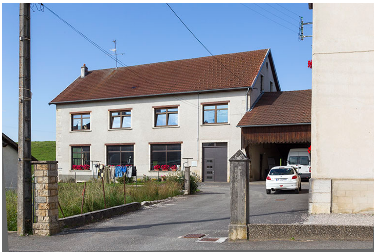
Ancienne fonderie : façade antérieure.
