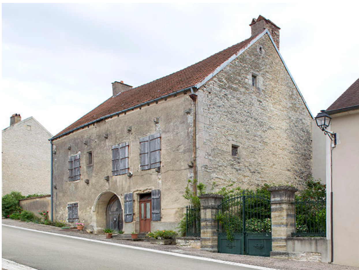
Vue générale de trois quart droite.
