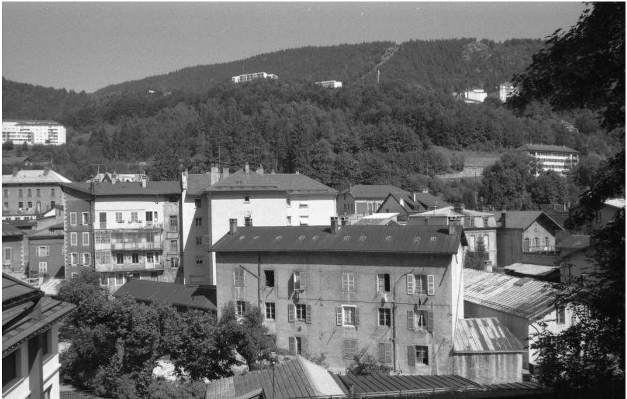
Immeuble et remise : façade sur la Bienne.
