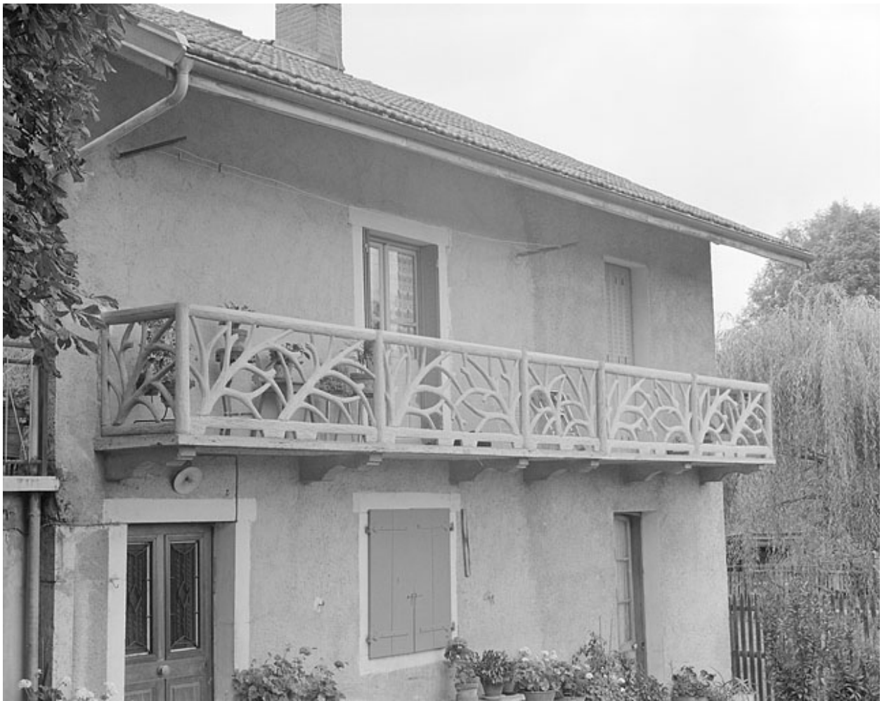
Garde-corps de balcon d'une ferme.
