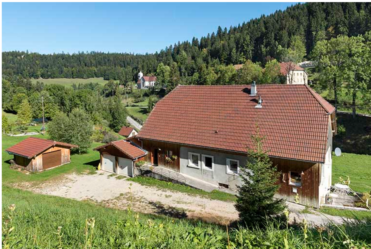
Vue plongeante sur la façade sud.
