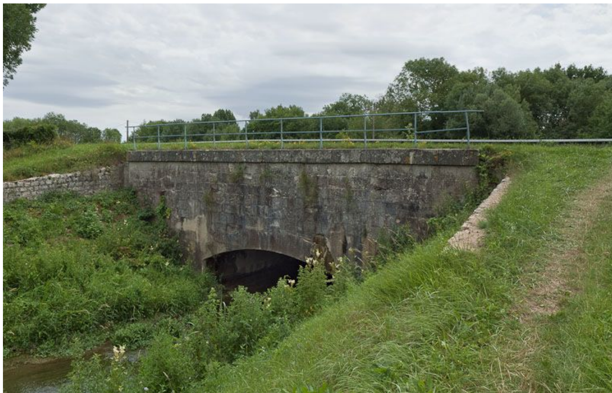
Vue de l'entrée de l'aqueduc.
