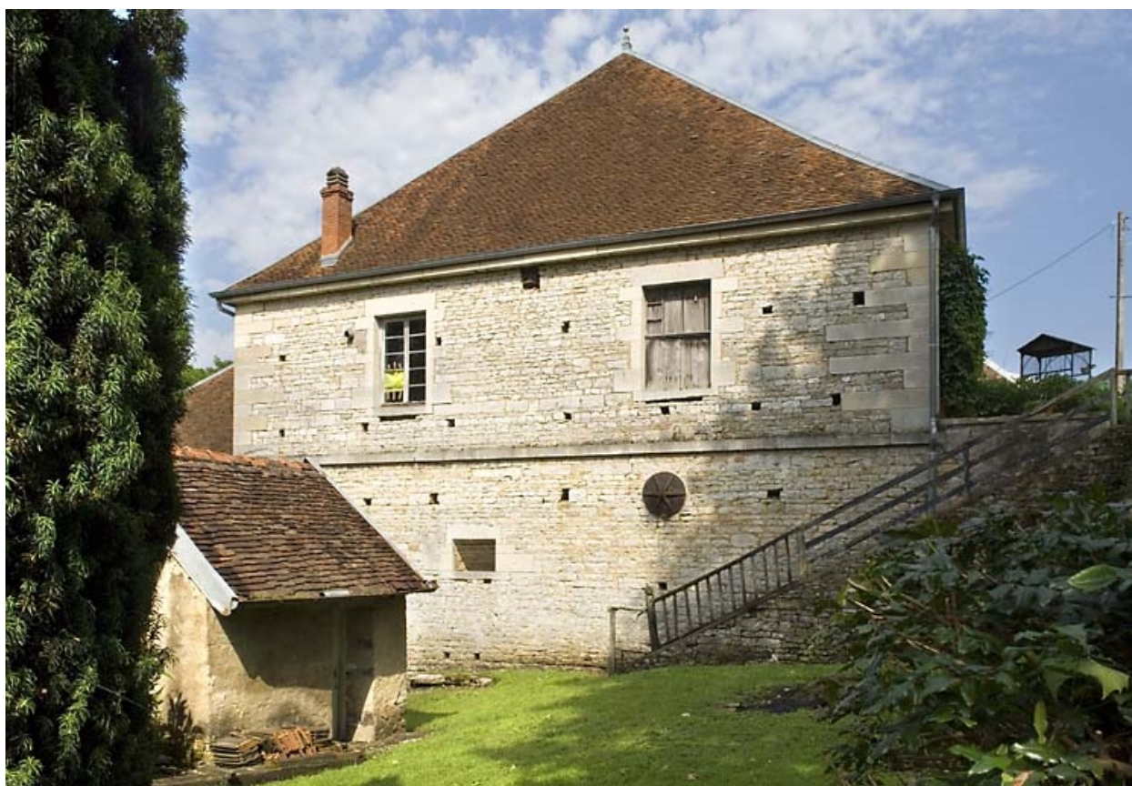
Façade ouest du haut fourneau.
