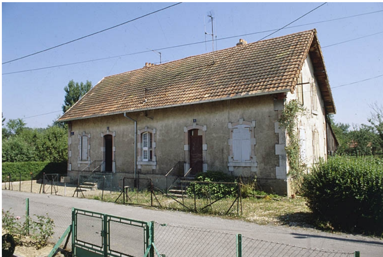
Maison à deux logements rue Rossat.
