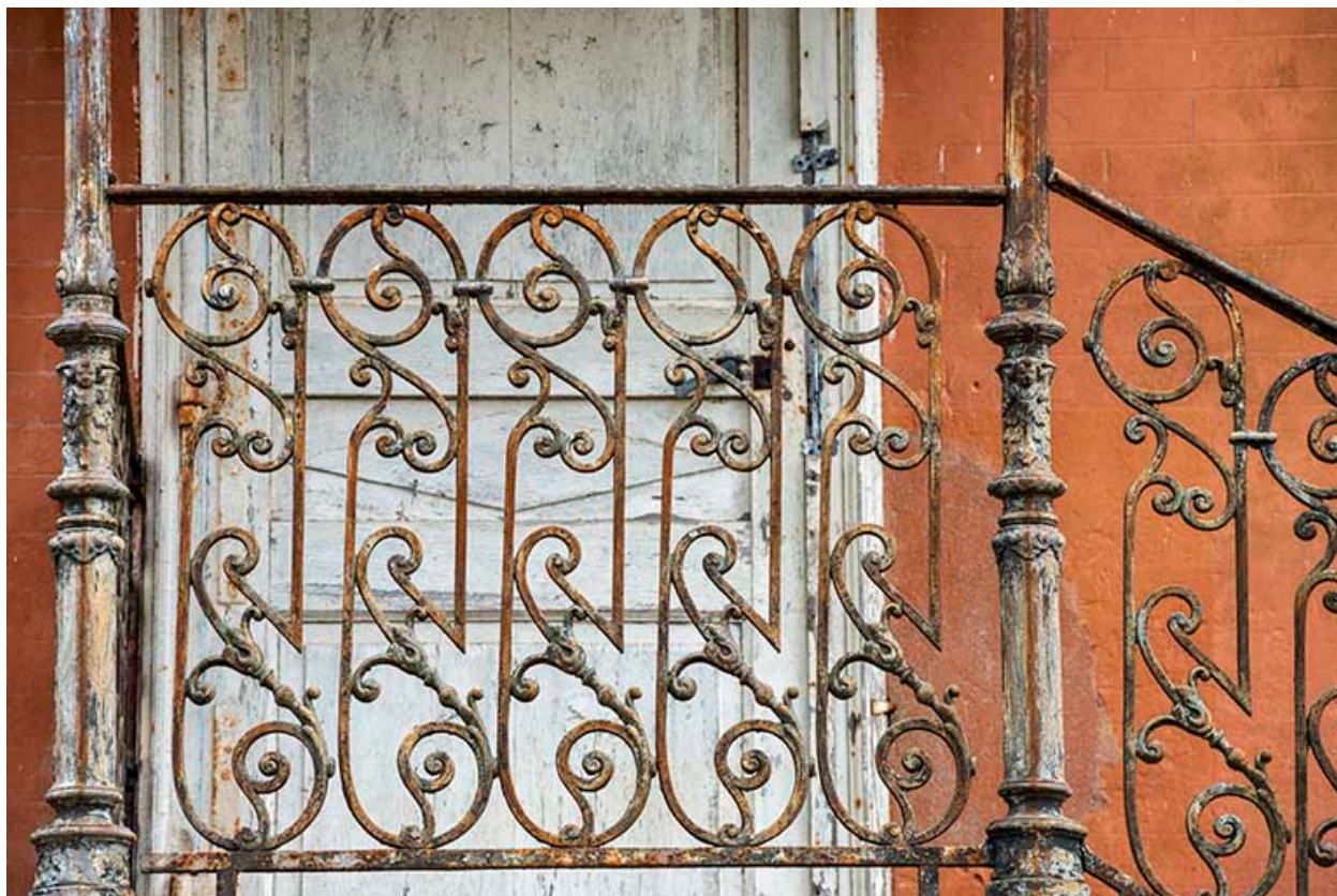
Garde-corps du perron.
