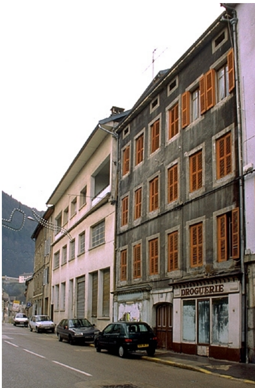
Façades postérieures de trois quarts droite.
