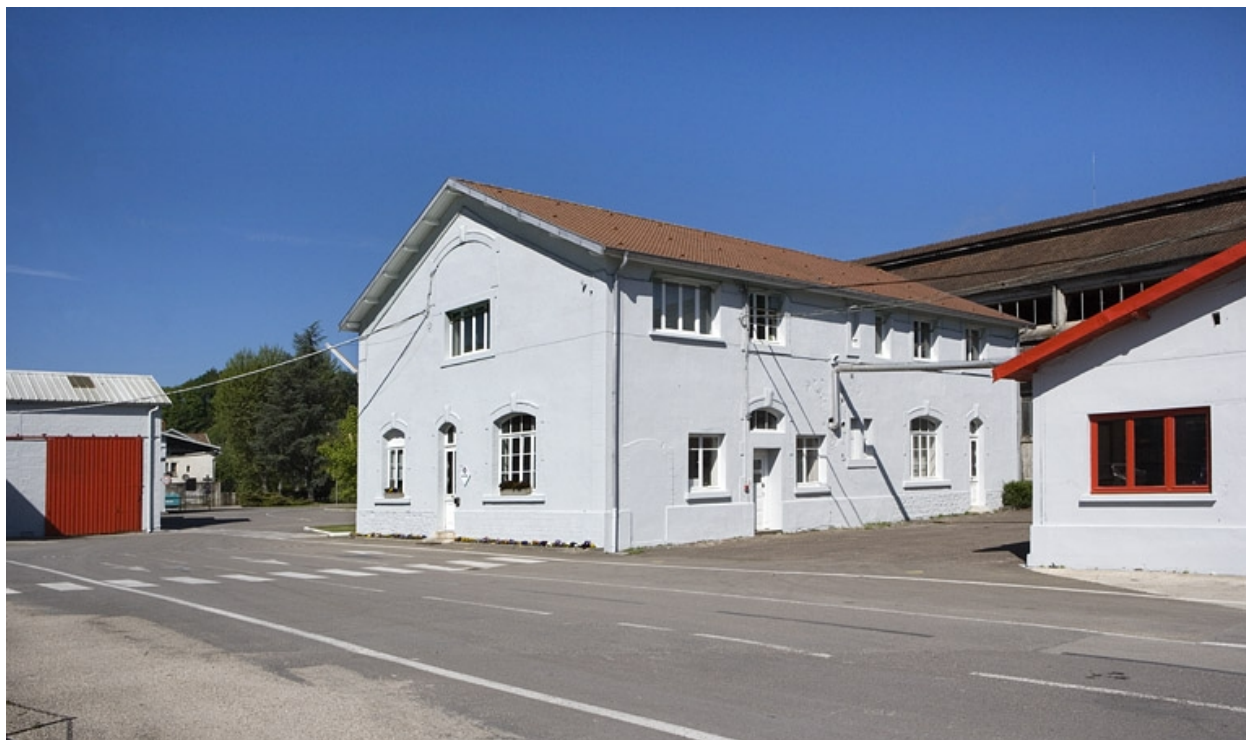
Bureaux. Vue de trois quarts droite.
