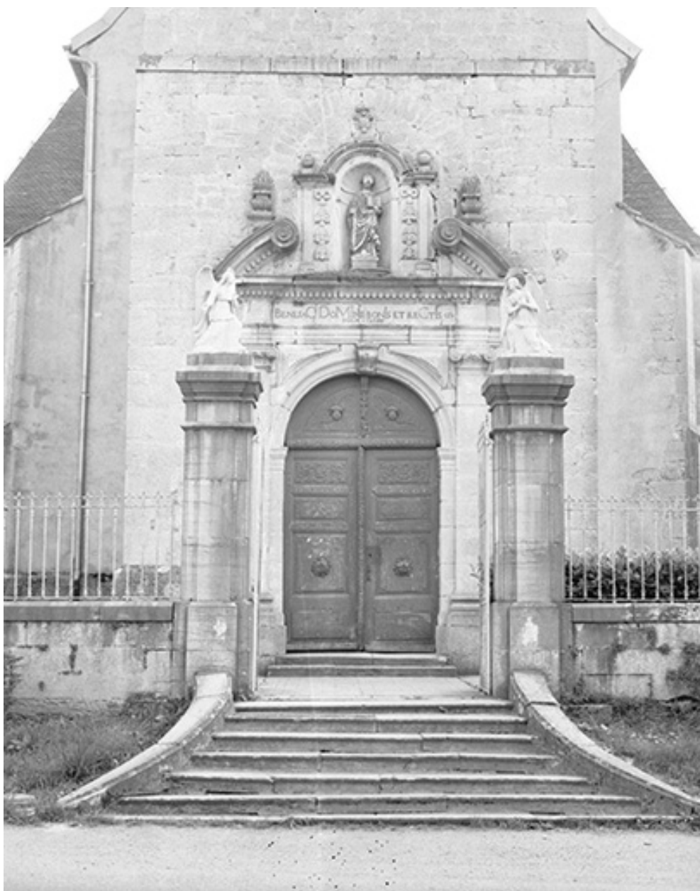
Façade antérieure et portail.
