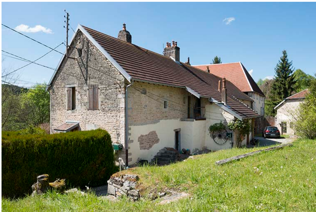
Logement patronal (maison du maître de forges).
