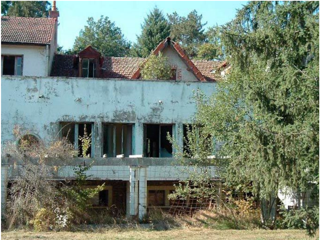
Bâtiment principal, façade antérieure, partie droite.
