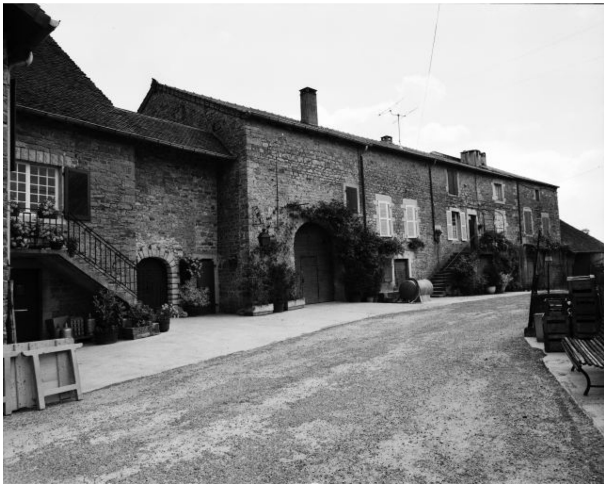
Fermes situées rue du Serin : vue d'ensemble.
