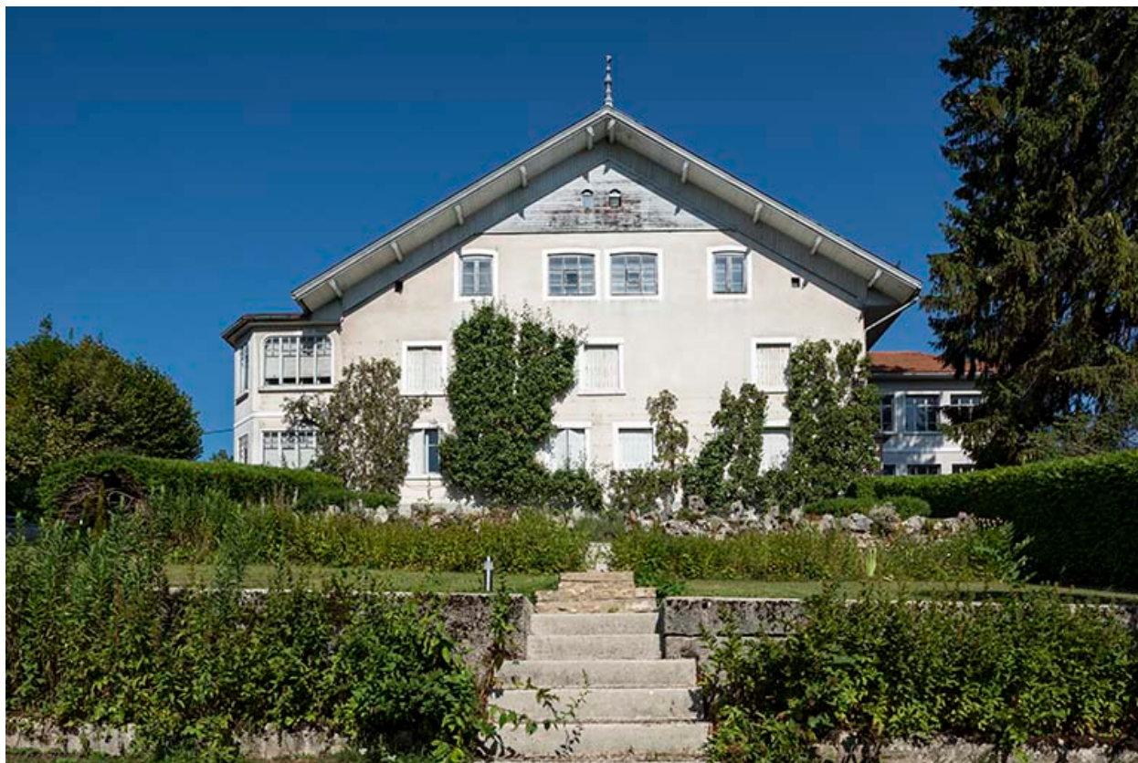
Ancienne ferme : façade latérale droite (est).
