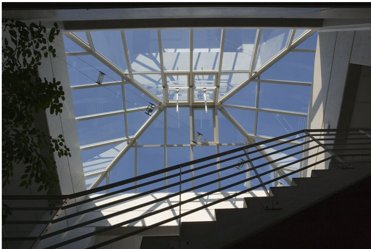
Bâtiment A. Détail de la verrière.
