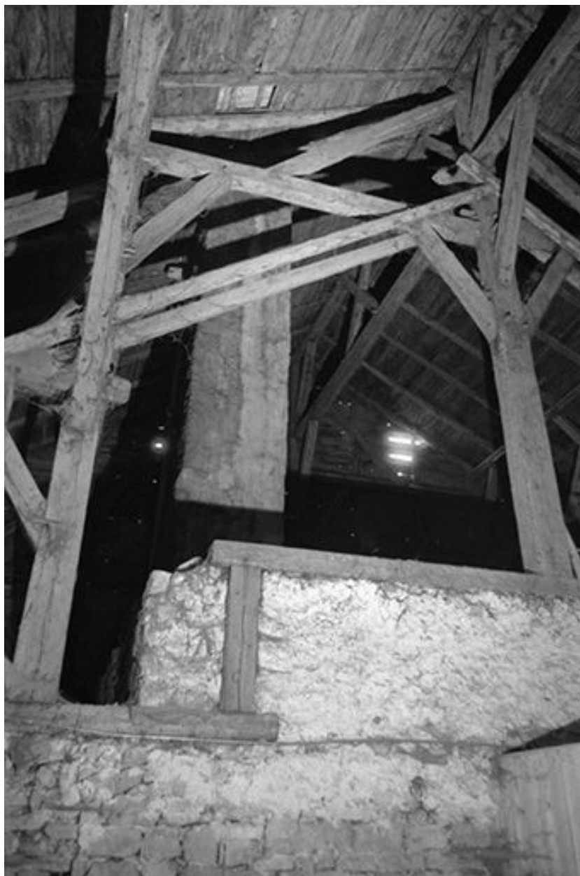
Intérieur : charpente et cheminée.
