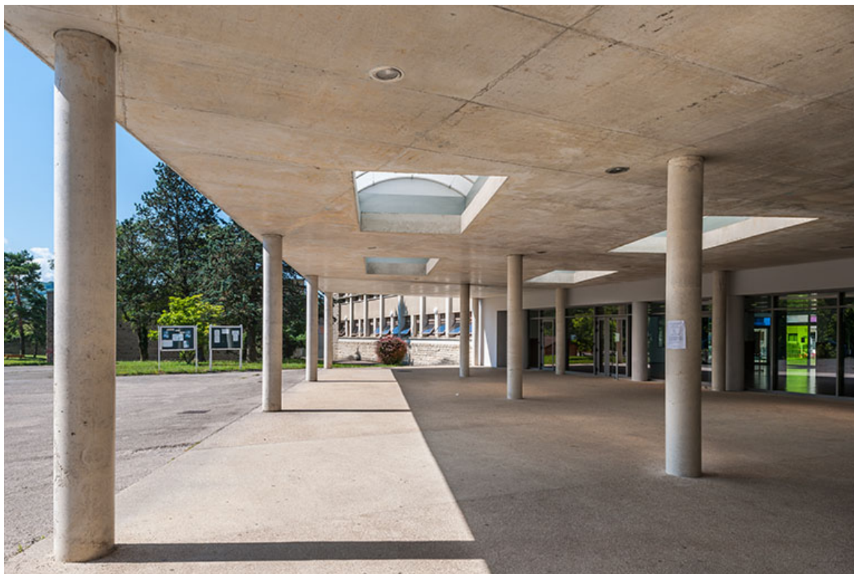
Liaison couverte entre bâtiments et préau.
