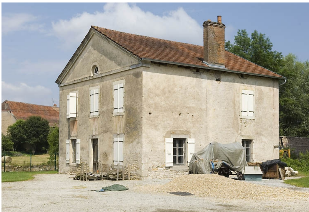
Logement patronal vu de trois quarts.
