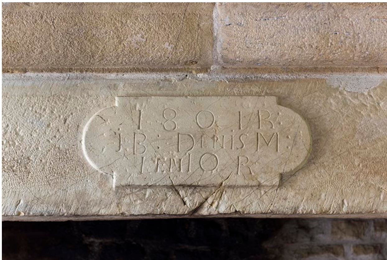
Détail sur le manteau de la cheminée.
