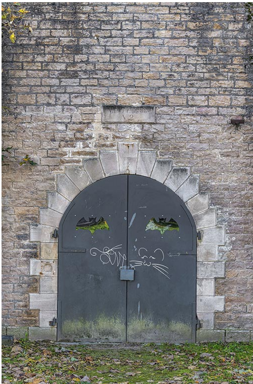
Site de l'ancien arsenal : magasin à poudre V2, porte d'entrée.
