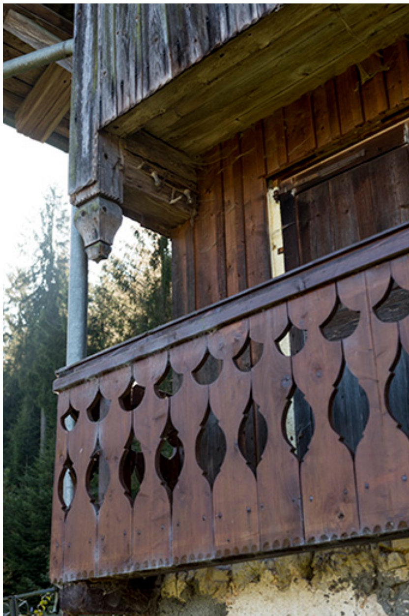
Façade postérieure : détail du garde-corps.
