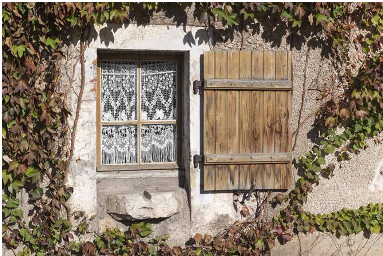
Façade sur la rue des Glacis, détail : la sortie d'évier (ou goulotte).
