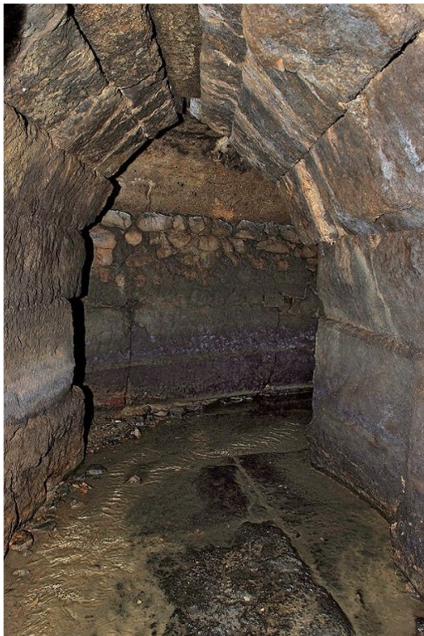
Section reliant les deux galeries.
