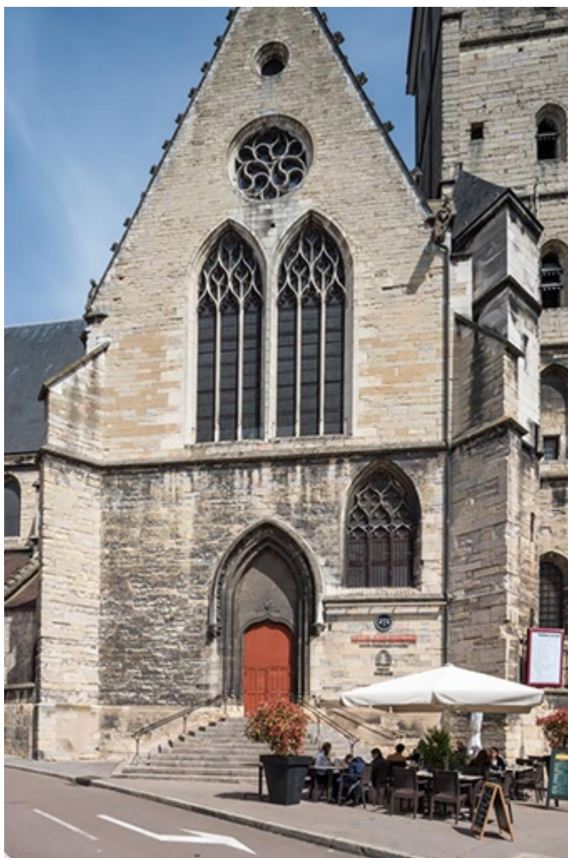
Façade sud : extrémité du transept.
