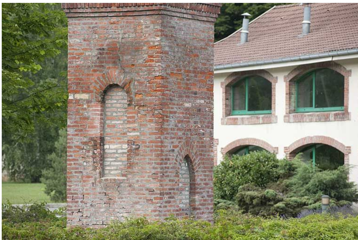
Soubassement de la cheminée carrée.
