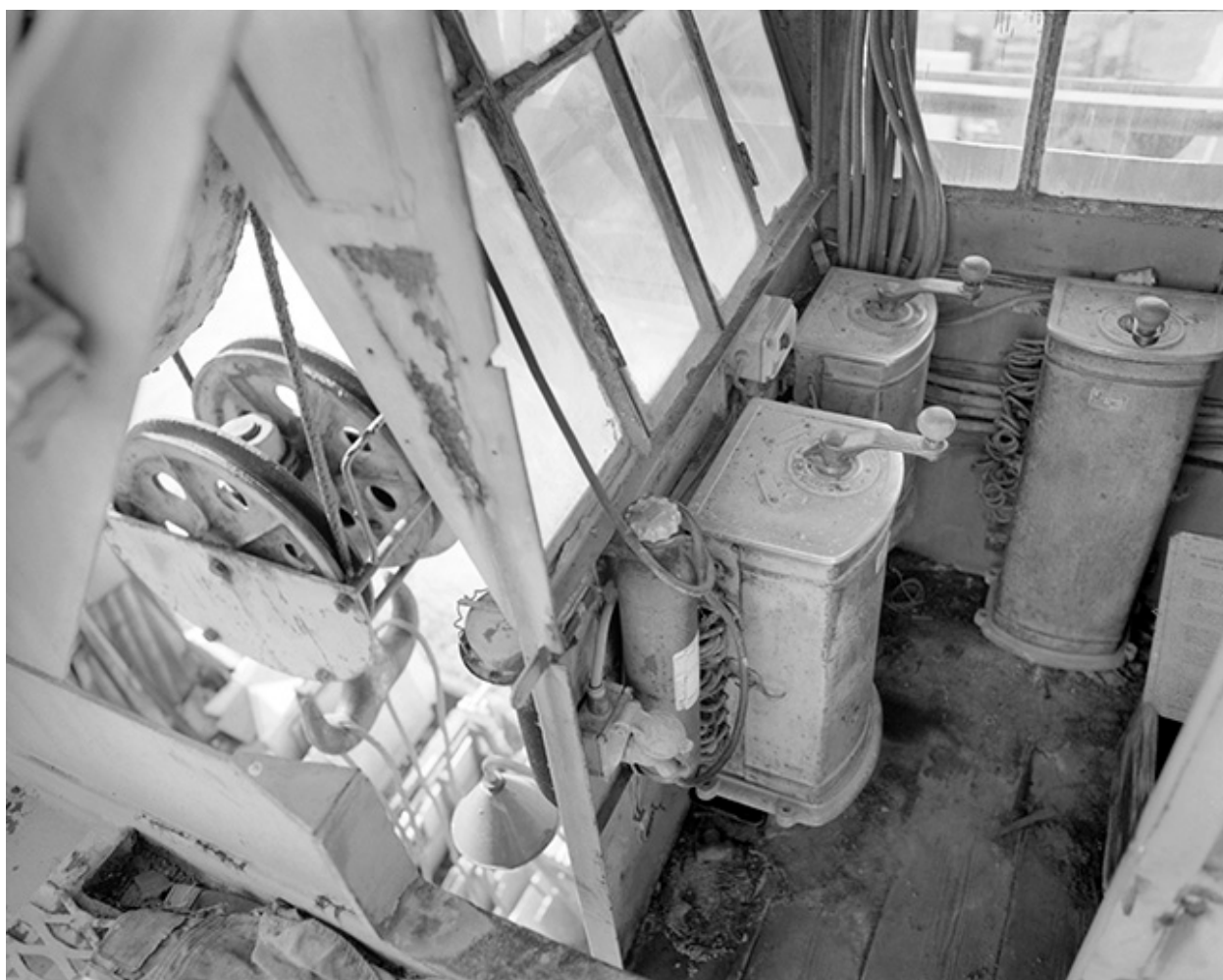
Intérieur de la cabine.
