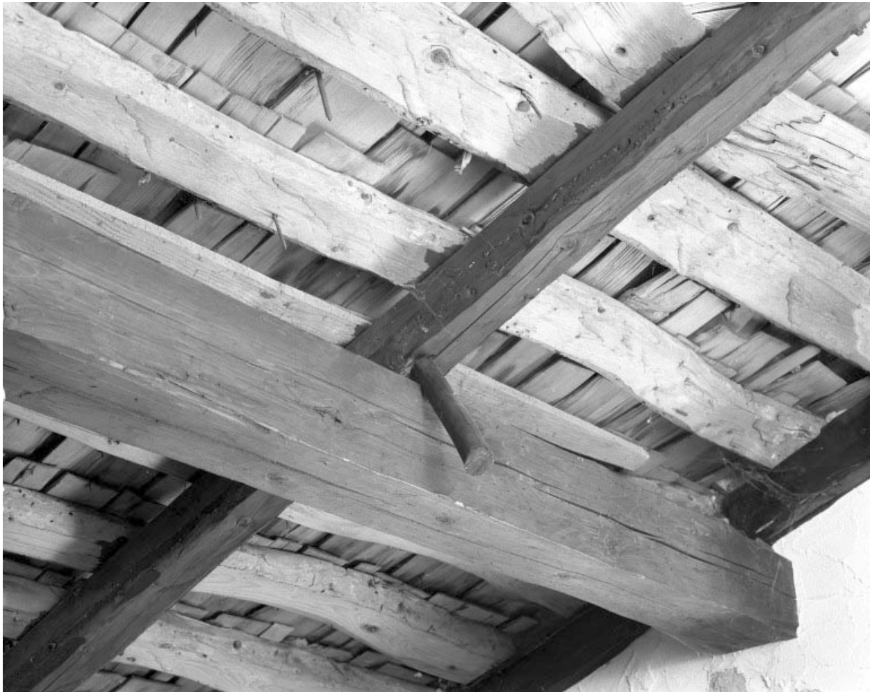
Détail d'une cheville en bois empêchant les chevrons de glisser.
