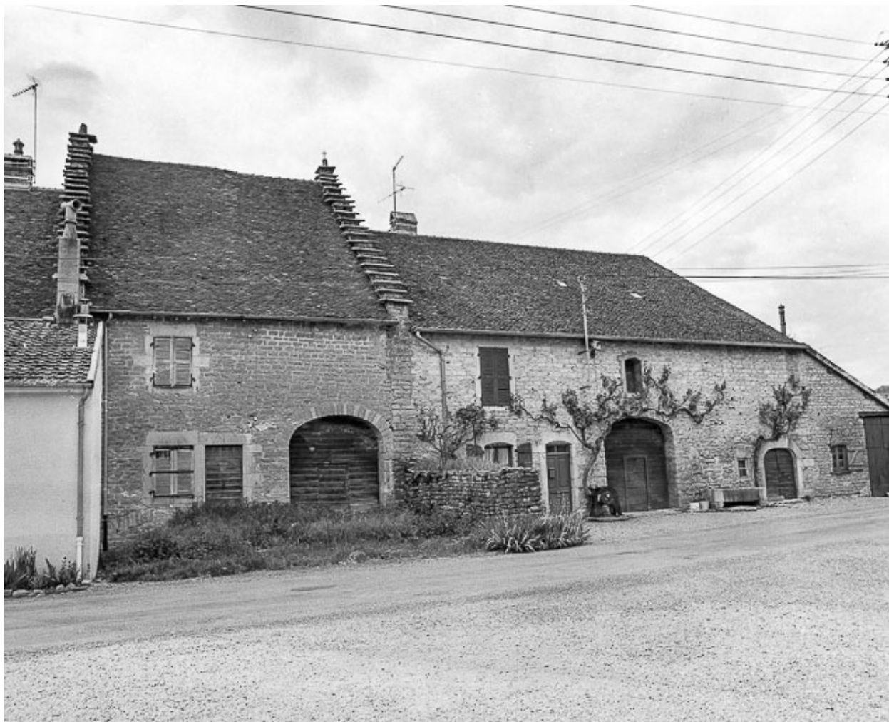
Fermes situées rue Roche : façades antérieures.
