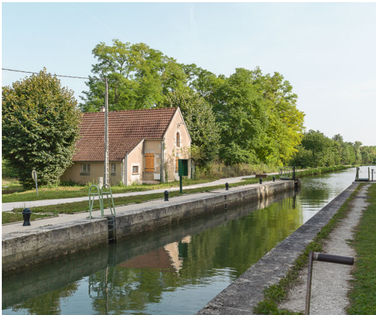
Vue du site d'écluse.
