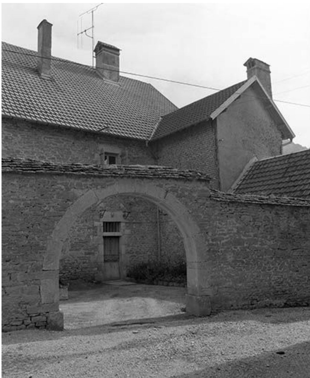
Détail de la façade antérieure : l'entrée.
