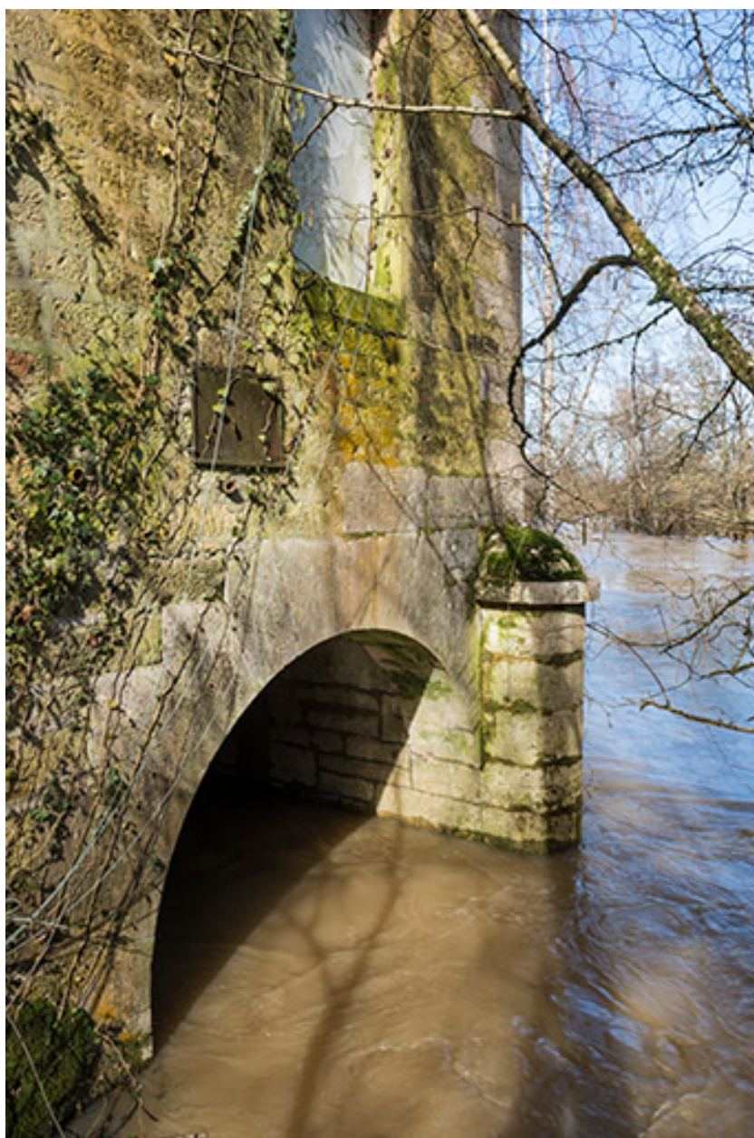
Canal de fuite du moulin.
