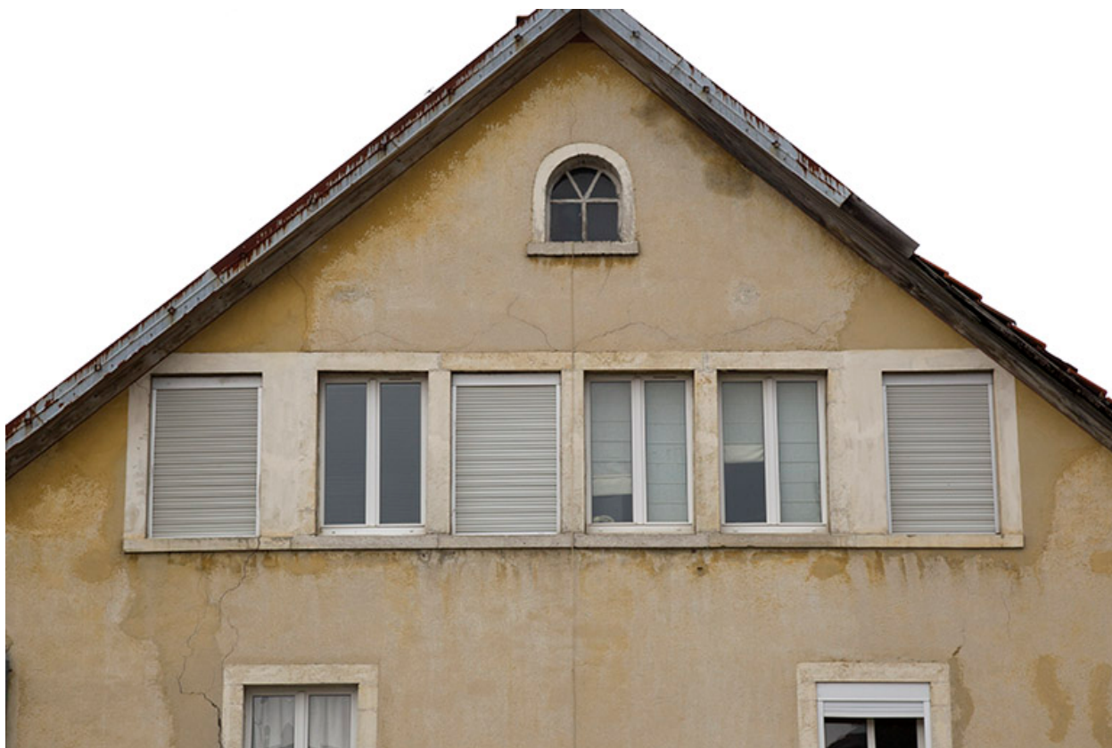
Façade postérieure en 2012 (avant rénovation) : fenêtres multiples.
