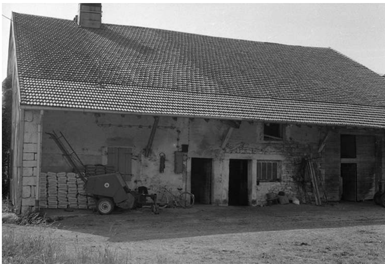
Façade latérale droite.
