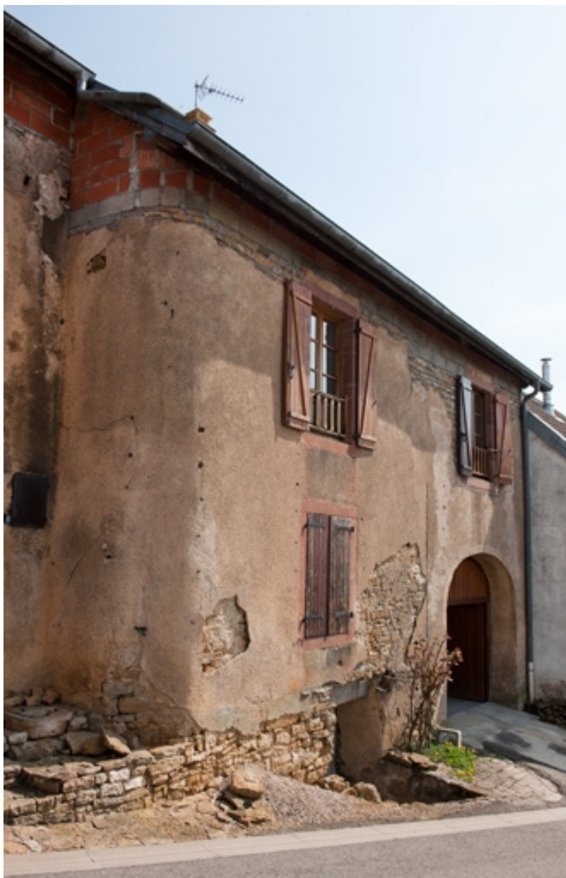
Vue rapprochée de la façade antérieure.
