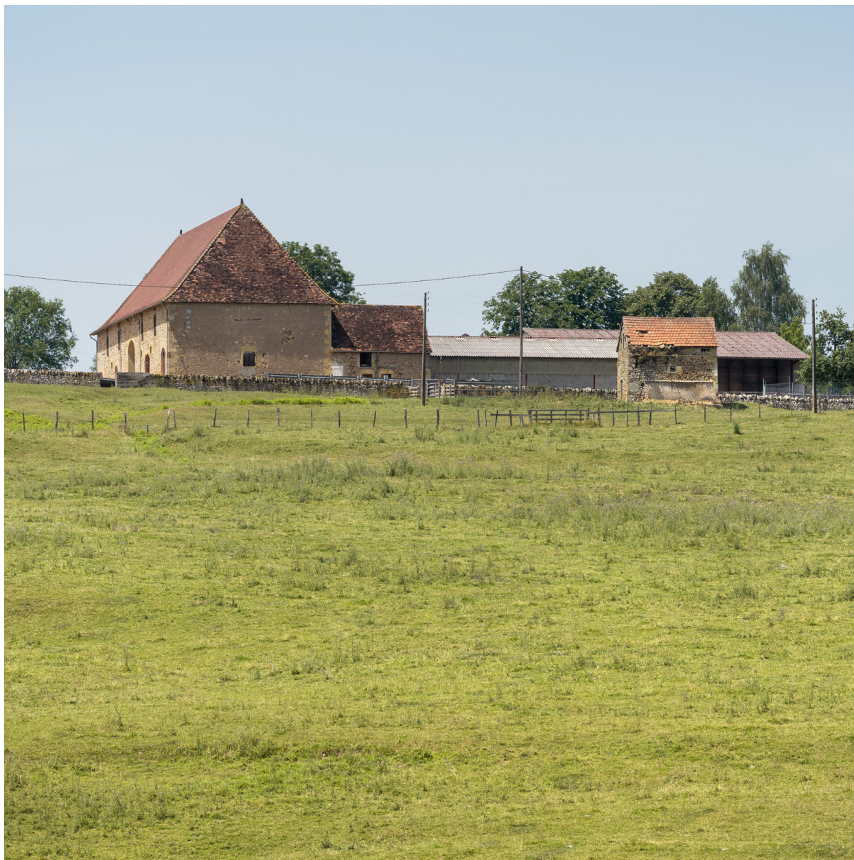
Les bâtiments agricoles vus depuis l'est.
