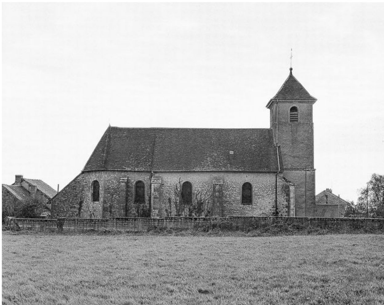
Façade latérale gauche.
