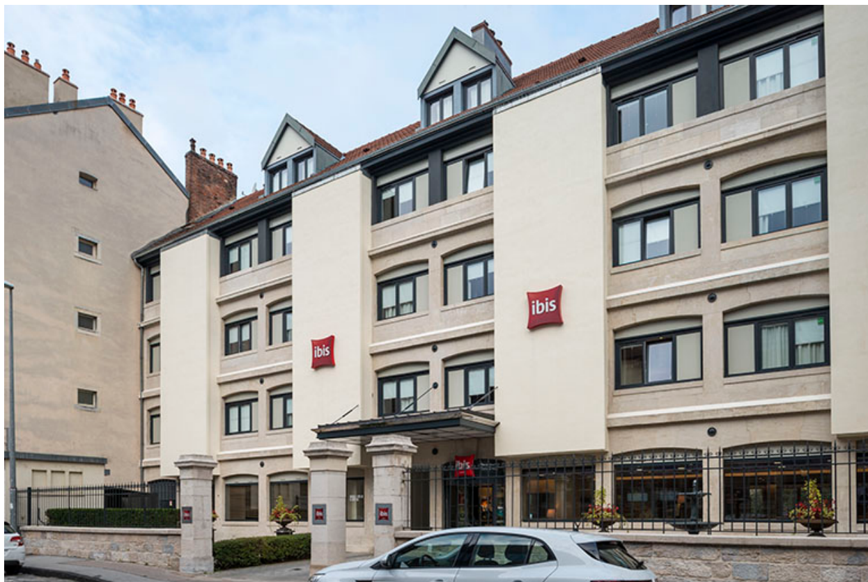
Façade antérieure vue de trois quarts droite.
