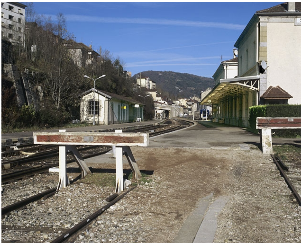
Vue d'ensemble des butoirs.
