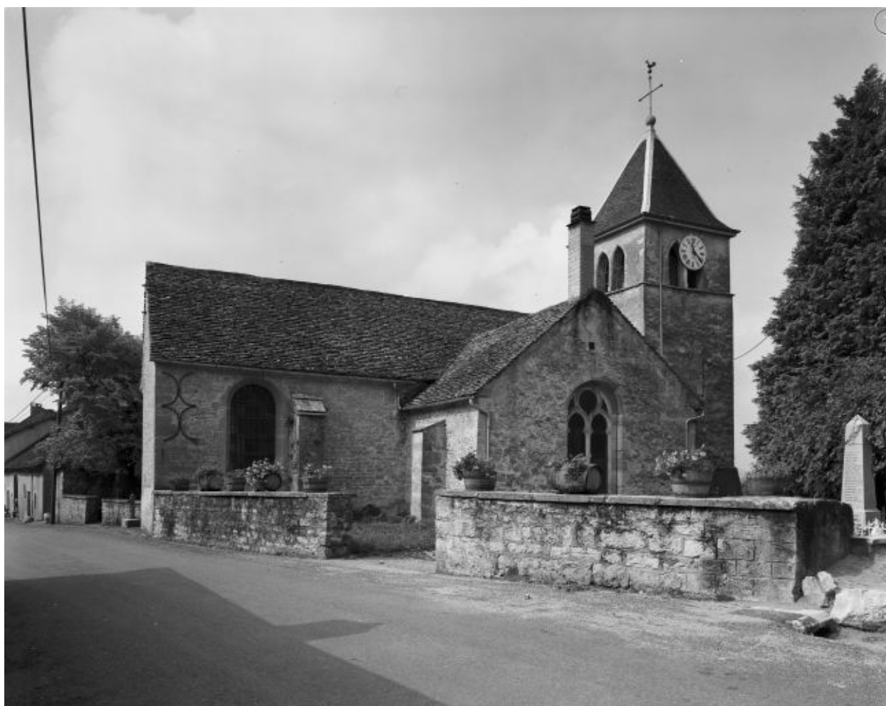
Vue d'ensemble extérieure.
