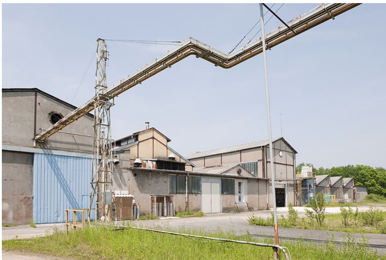
Pignons des bâtiments industriels depuis le sud.
