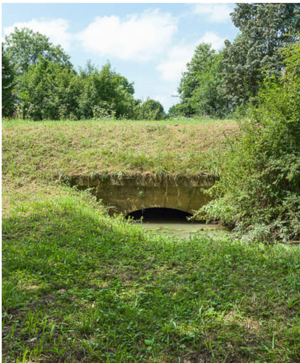
Vue de l'aqueduc.
