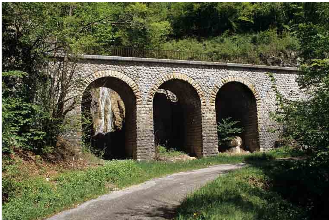
Viaduc, vu de trois quarts gauche.
