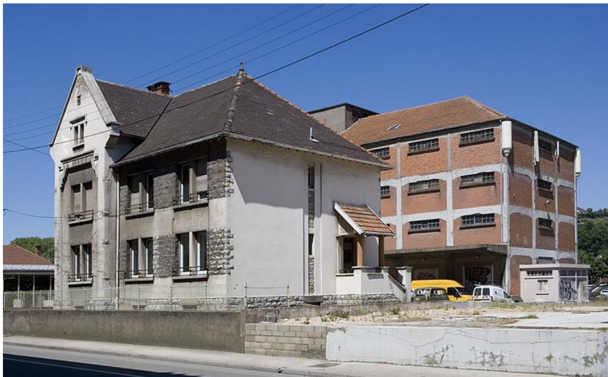
Bureau : façade antérieure de trois quarts droite.
