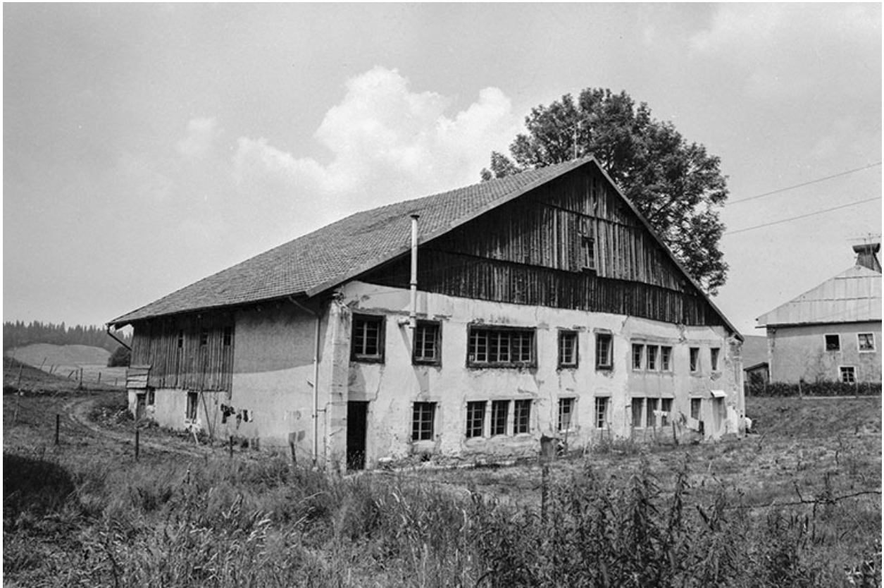
Façades antérieure et latérale gauche, en 1976.
